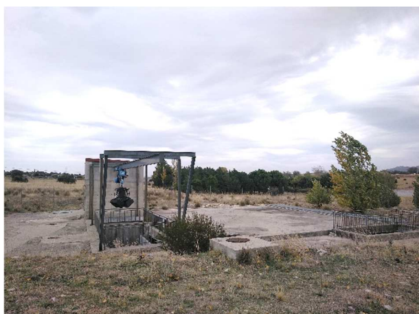
Foto: Tanque de tormentas.
